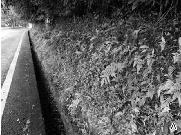
高知市針木北，道路法面，テープで囲まれた範囲が調査区 (2014. 5. 5).
